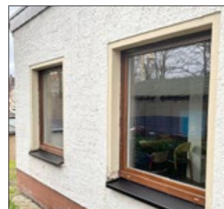
Im Sportlerheim wurden alle 8 sanierungsbedürftigen Fenster ausgetauscht.
