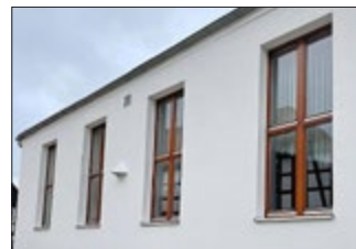
Teilerneuerung der Fenster des Schwansaals.
