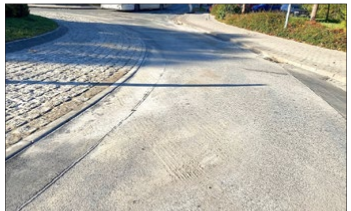
Sanierter Abschnitt des Kreisverkehrs
