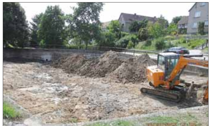
Ein weiteres Vorhaben war die Entschlammung des Dorfteiches am Backhaus
