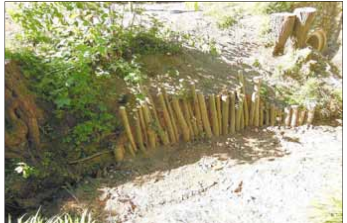
Uferbefestigung im Kaisertal mittels Stecklingen zur Verhinderung von Ausspülungen
